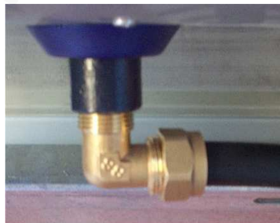
Fig 13.- Conexiones circuito primario. Tubo largo.
