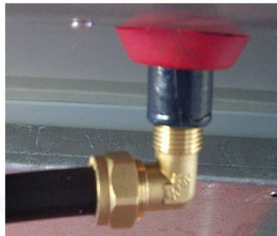
Fig. 12.- Conexiones circuito primario. Tubo corto.
